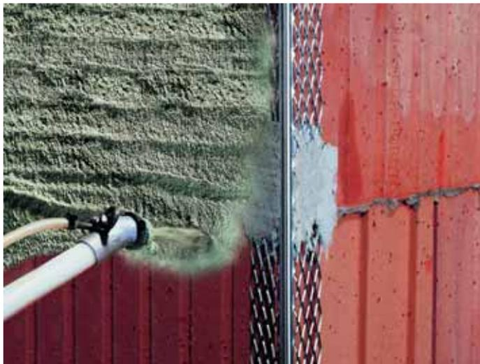
Легкая штукатурка с органическими пористыми заполнителями должна использоваться при наружных работах только в качестве нижнего слоя штукатурной системы. При наружных работах на все виды легкой штукатурки не разрешается наносить органический верхний слой (штукатурки на основе синтетических полимеров).
