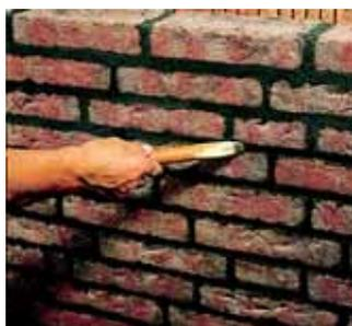
верхность швов, в результате – прочное сцепление кирпича с основанием, однородная герметичная структура шва, водонепроницаемая, морозостойкая и погодостойчивая кладка;
