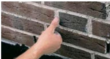
4. Хорошо зарекомендовали себя при этом такие инструменты, как щепа, кусок шланга, расшивка и др. Швы при расшивке надавливая приглаживают. В зависимости от обработки (шлангом или щепой) получается гладкая или шероховатая поверхность швов. Цвет шва при этом зависит в основном от консистенции раствора в момент разравнивания поверхности шва. Поэтому обработка шва должна всегда производиться раствором одинаковой твердости.
