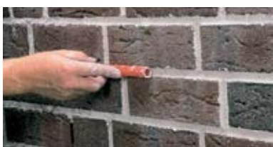
5. Результат: Прочное сцепление кирпича с основанием, однородная герметичная структура шва, водонепроницаемая, морозостойкая и погодоустойчивая кладка.
