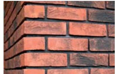
Как видно на следующем рисунке, из-за углубления шва в нем скапливается вода, которая может через кладочный раствор в шве проникать в пустоты облицовочного кирпича. Скопившаяся здесь вода растворяет растворимые компоненты вяжущего. Впоследствии образуются нежелательные выщелачивания.
