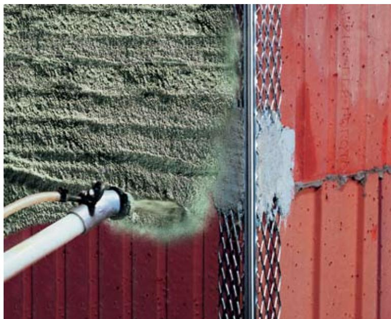
Позже были разработаны легкие штукатурки с более низкой плотностью затвердевшего раствора в пределах 600-1200 кг/м<sup>3</sup>, которые обозначаются как «Легкие штукатурки, тип II».
