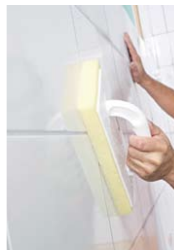
5. FBR 300 – Заполнение швов
