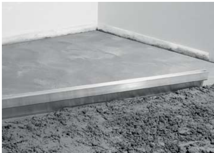
2. В 04/ZE 04 – Устройство стяжки
