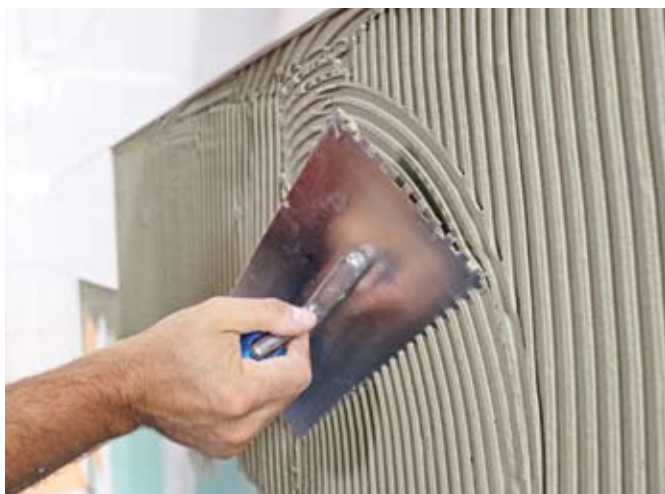
4. FX 900 – Укладка плитки
