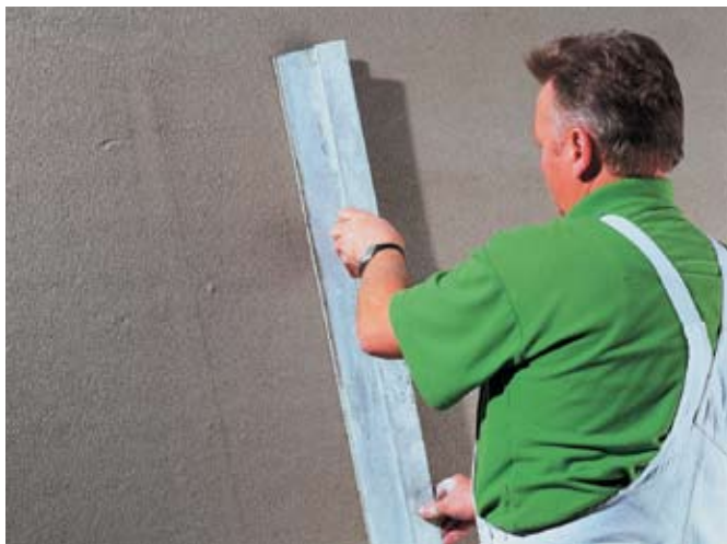
1. МК 3h – Оштукатуривание стен
