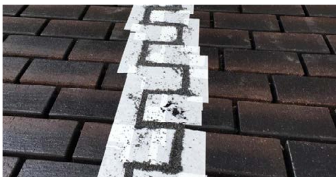
Рис 1.2 (д). Пример расположения температурных и деформационных швов при мощении территории индивидуального частного участка
