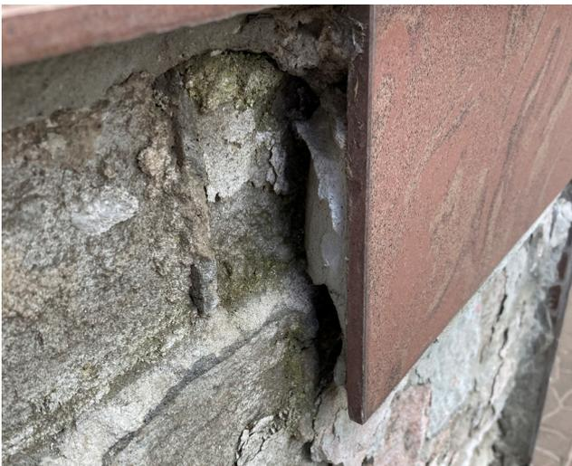
На углах конструкций не делают температурно-компенсационный шов и просто стыкуют плиты без зазора, в крайнем случае зазор заполняется жесткой цементной затиркой для швов. Это приводит к растрескиванию облицовки и швов:
