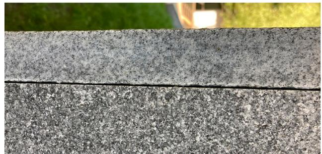
Отсутствие температурно-компенсационных швов, узкие межплиточные швы и применение неэластичного плиточного клея приводят к появлению трещин в облицовочных плитках:
