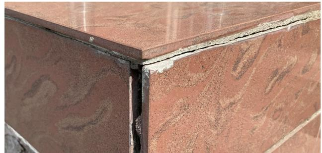
Межплиточные швы делают узкими без учета размеров и массы укладываемой облицовки:
