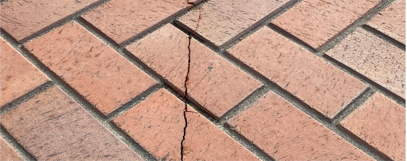
Вырезаем и выбиваем клинкерную брусчатку до подстилающего слоя
