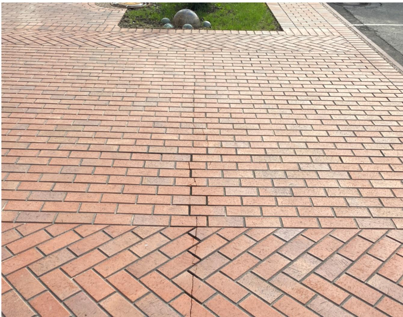
Существующая трещина, проходящая через клинкерную брусчатку
