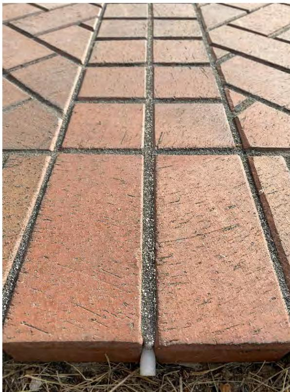
Общий вид выполненной работы по ремонту трещины в покрытии из клинкерной брусчатки
