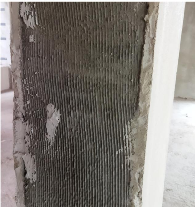
При использовании грунтовочных и адгезионных продуктов необходимо обращать внимание на рекомендованное время высыхания и схватывания материала перед нанесением последующих покрытий. Последующие покрытия необходимо наносить только после полного высыхания грунтовочного слоя или схватывания адгезионного раствора. Недостаточная выдержка, перед нанесением последующего слоя, при физическом воздействии может привести к разрушению этого еще несформировавшегося слоя.
