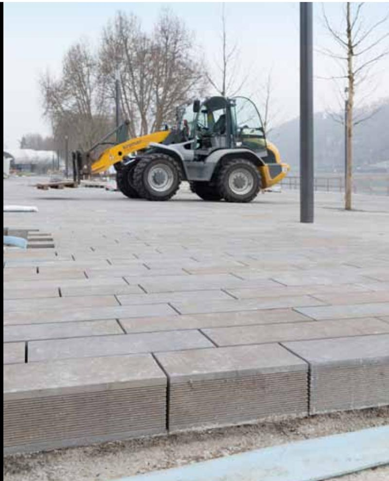
Для оптимизации прочности сцепления между раствором для заполнения швов брусчатки «PFN» и элементами покрытия из граувакки была использована инновационная технология нанесения канавок на торцевые и боковые поверхности камней. Это позволило увеличить прочность сцепления на 40%.
